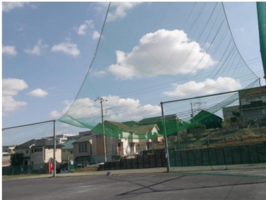
2丁目、青葉スポーツプラザ、 防球ネットを上部に設置
